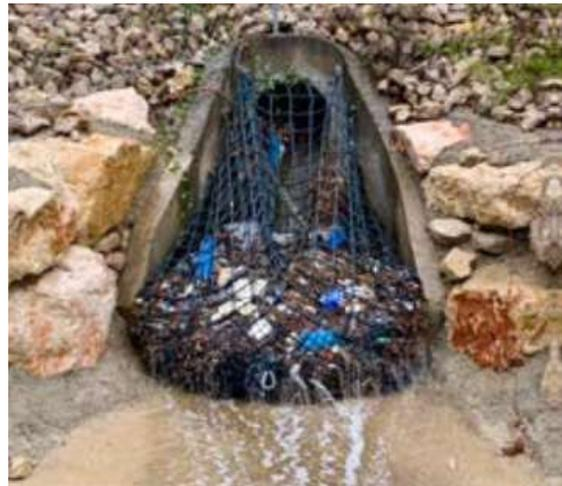
Le choix des sorties pluviales équipées de filets aura été fait notamment en fonction de l'accessibilité routière pour l'approche avec un véhicule et des possibilités d'intervention manuelle pour les décrochages/fixations et la manipulation des filets.
