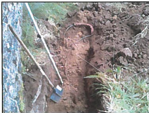
Figure n°9 : Photo de l'excavation réalisée (source : ARCADIS)
