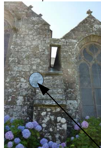
Façade Nord ( zone de carottage )
