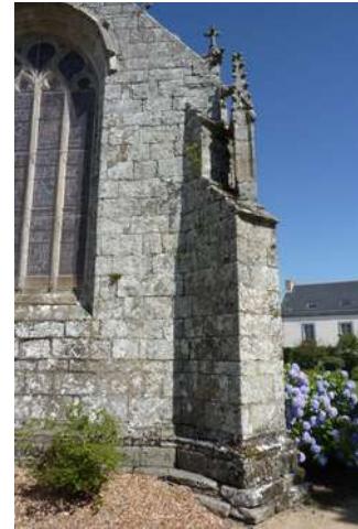
Contrefort de l'angle Sud-Est
