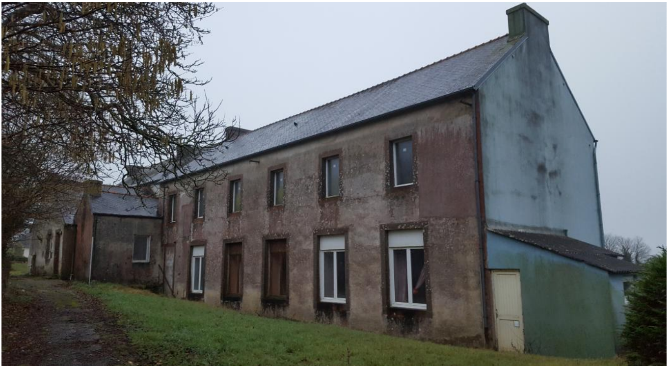
Arrière du bâtiment
