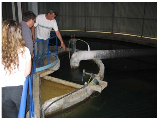
Usine de production de Milin Izella, de droite à gauche : poste de pompage, tour de pré-ozonation et décanteur
