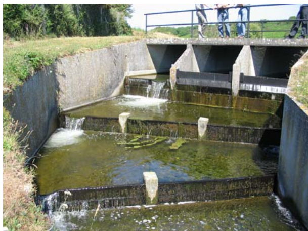
Surverse et vanne de fond de la réserve de Kerescar
