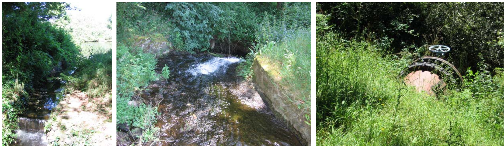
Surverses et vanne de fond de la « Réserve du Moulin du Haut »
