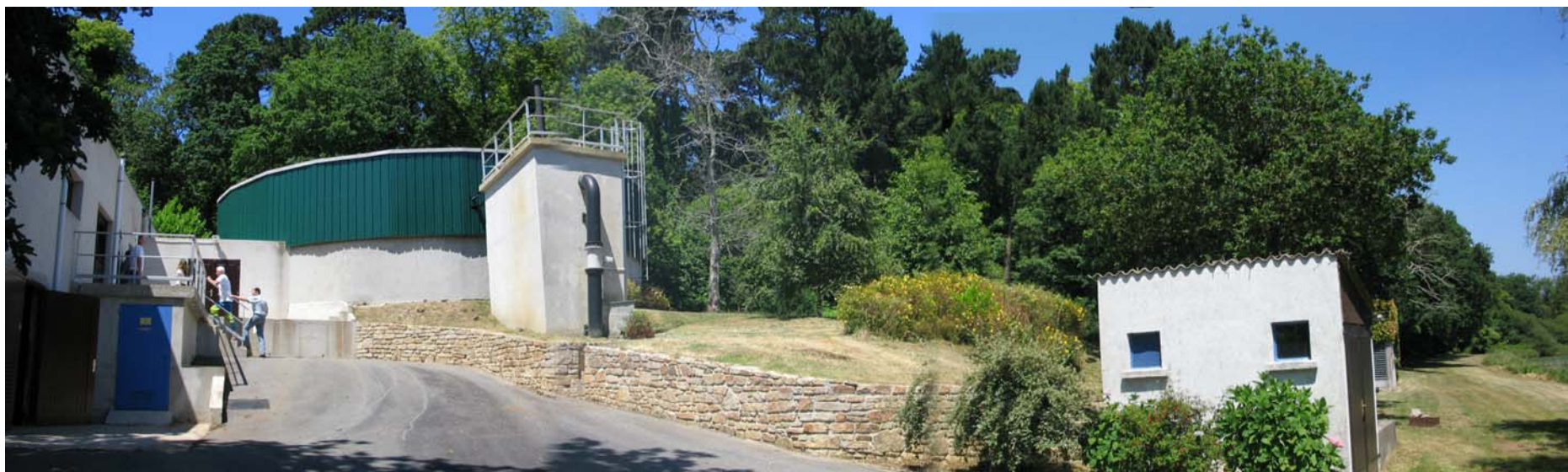
Usine de production de Milin Izella, de droite à gauche : poste de pompage, tour de pré-ozonation et décanteur
