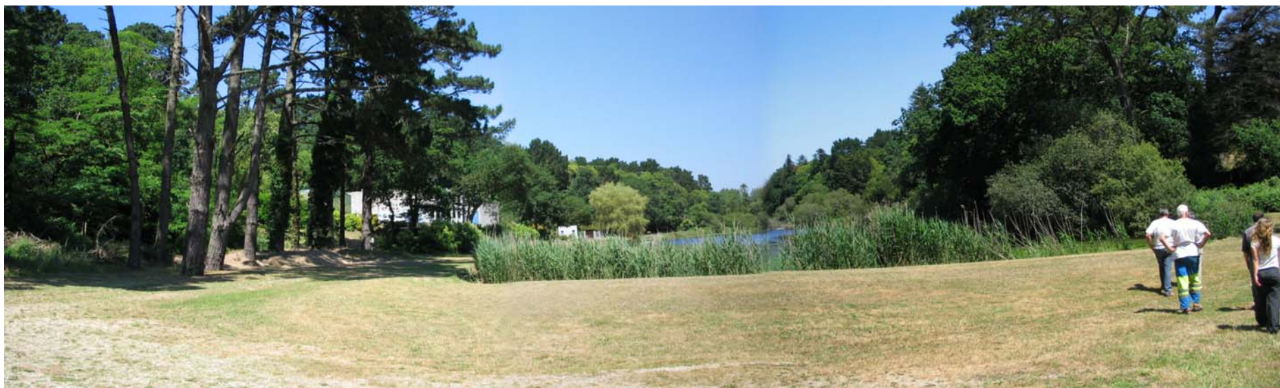
Retenue de Kermorvan et usine de production
