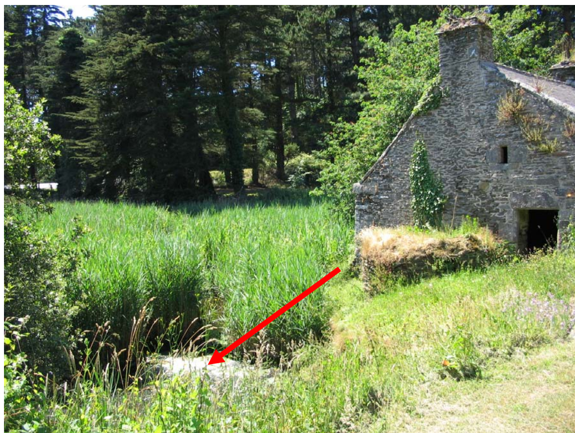
Point de rejet des eaux de rinçage des filtres
