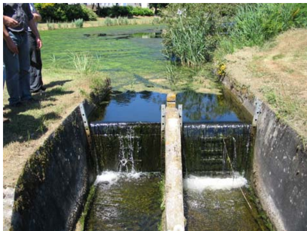
Surverse et exutoire de la retenue de Kermorvan
