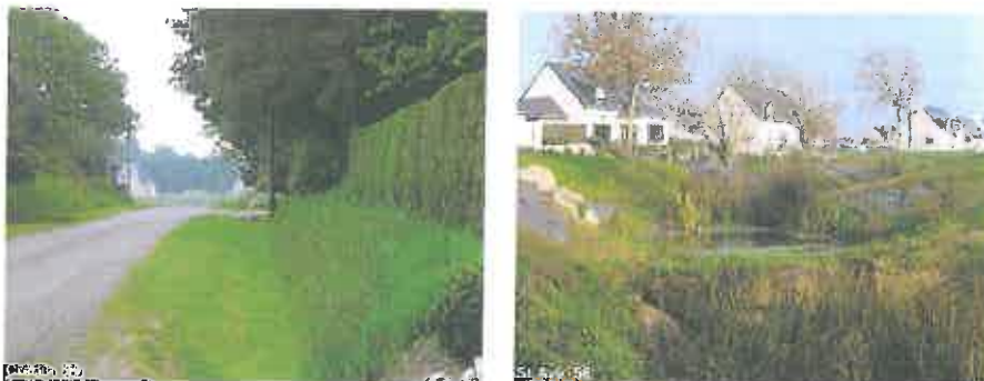
Les noues ou fossés permettent de collecter, stocker et assurer la restitution progressive de l'eau dans le milieu naturel par un système de petites retenues situées sur leur parcours.
