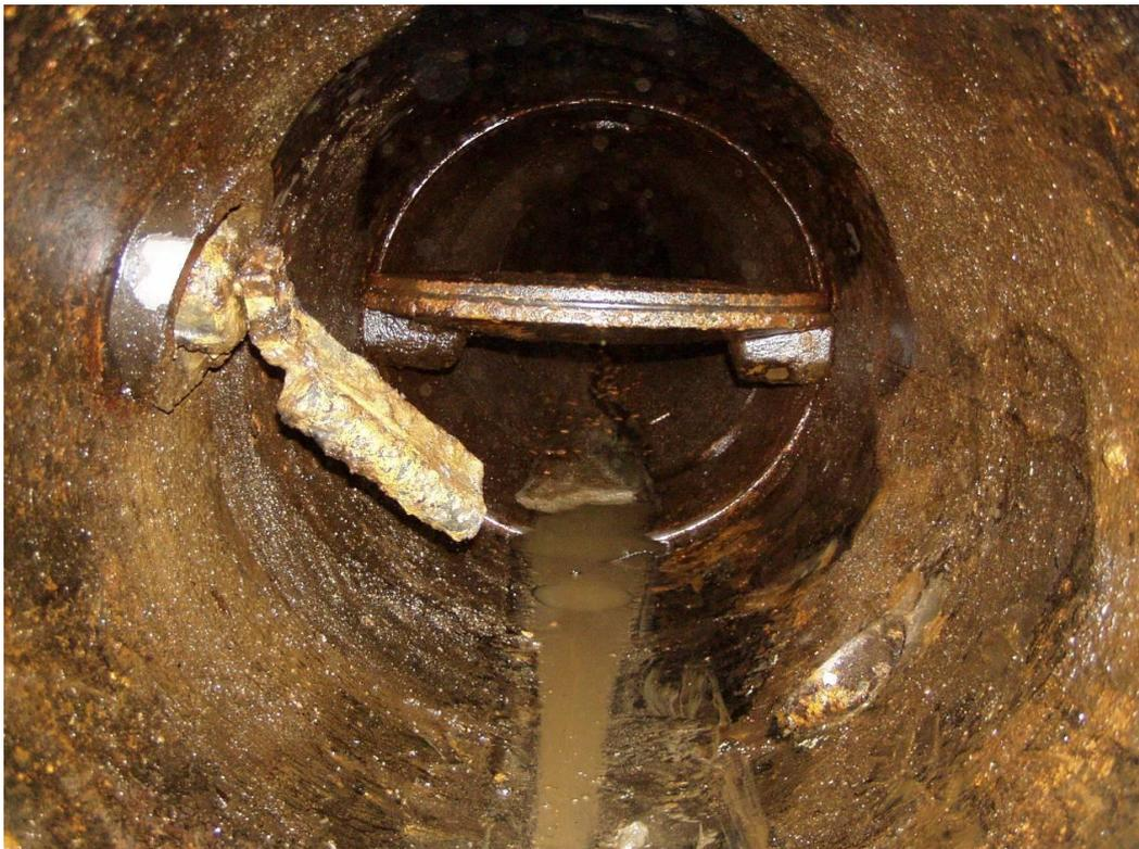
**Photo 10 : Vanne de survitesse et conduite de prise DN800**
