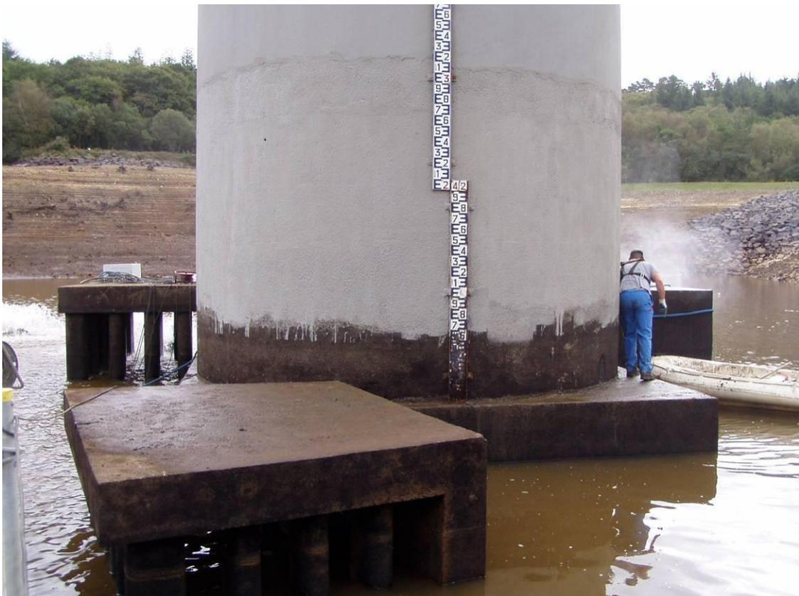
**Figure 4 : Vue du pied de la tour tulipe - Entonnement de prise d'eau au premier plan
