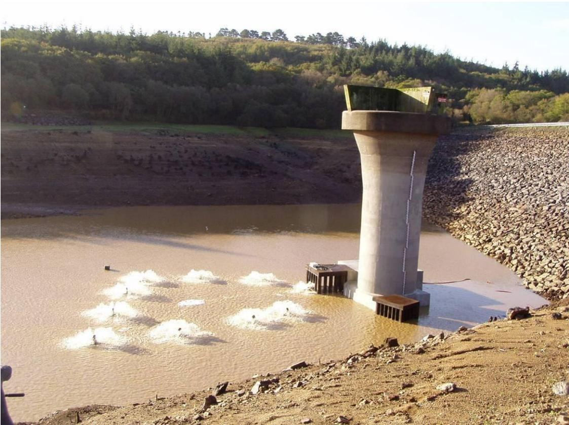
**Photo 1 : Vue de la tour tulipe et du parement amont lors de la vidange faite en 2006 – A gauche de la tour l'entonnement de vidange – A droite de la tour l'entonnement de prise d'eau**
