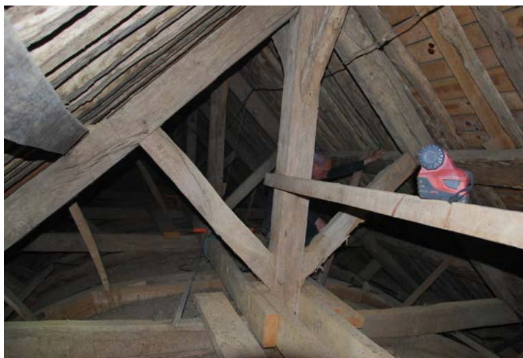
Vue d'ensemble des combles de la nef.
