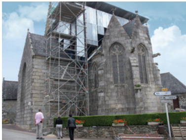
Chantier de restauration de l'Eglise Saint-Blaise
