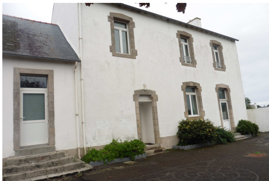
façade Est côté cour
