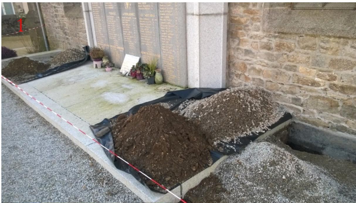
1: sondages janvier 2017; pas de drain traversant sous la dalle centrale
