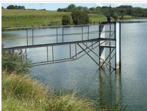
Etang de Kerescar – Vanne de fond (vue amont)
