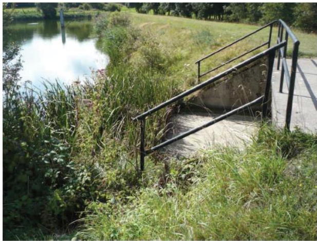
Etang de Kerescar – Trop plein (vue amont) Niveaux d'eau gérés par des bastaings.
