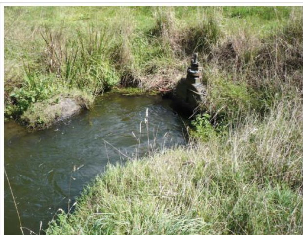
Etang de Kerescar – Vanne de fond (vue aval)
