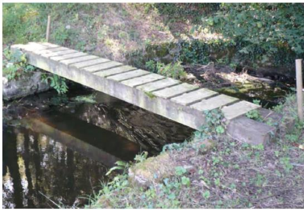
Etang du Haut - Trop plein
