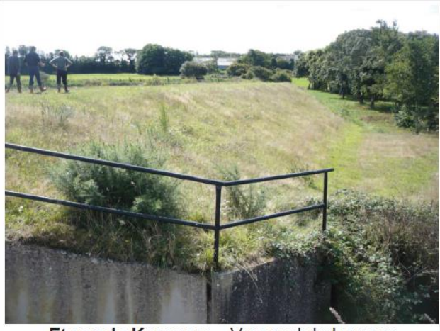
Etang de Kerescar – Vue aval du barrage
