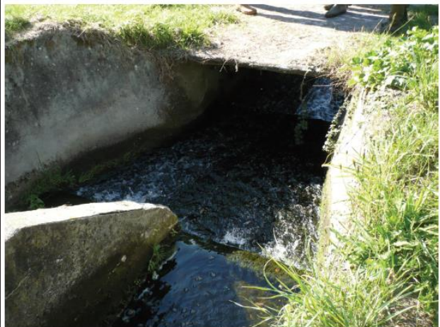
Aval du trop plein de la retenue de Milin Izella
