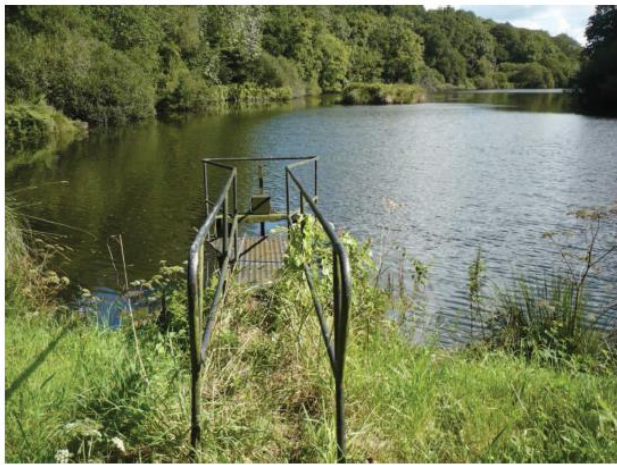
Réserve intermédiaire – vanne de fond
