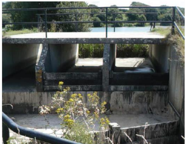
Etang de Kerescar – Trop plein (vue aval)
