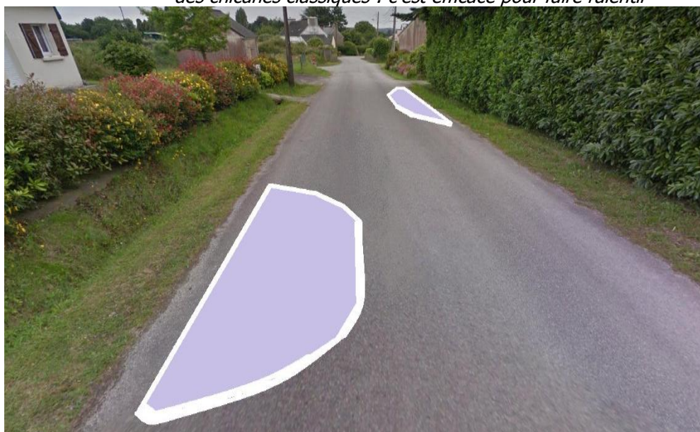
Exemple1 : chicane franchissable îlot dome + pavés
