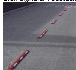
Exemple 3 : séparateur de chaussée scellé à la route + marquage routier = bande blanche pour bien signaler l'obstacle
