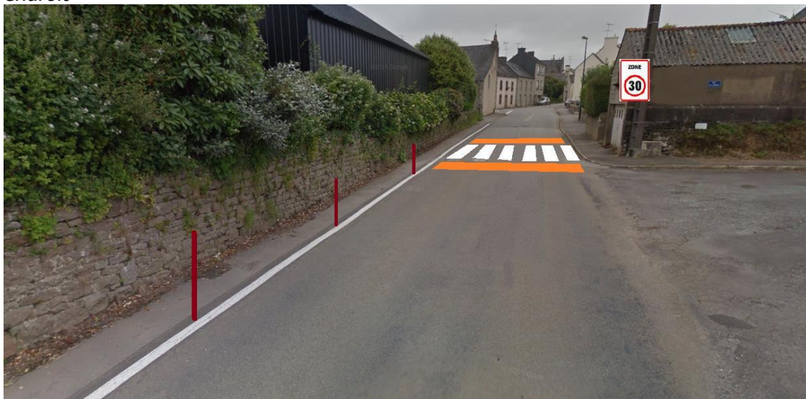
Exemple de passage piéton renforcé en mortier hydraulique type ROXEM
