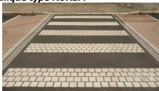
Exemple de passage piéton renforcé en mortier hydraulique type ROXEM
