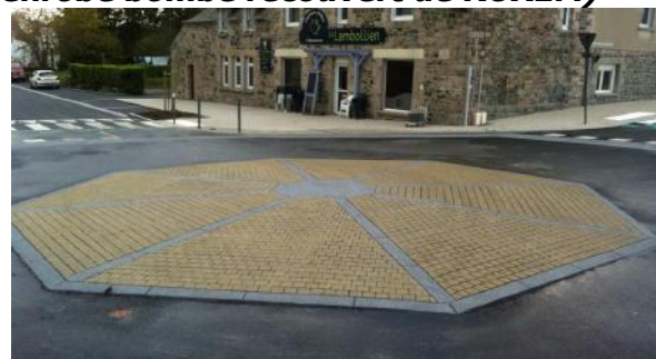
Exemple (îlot enrobé bombé recouvert de ROXEM)
