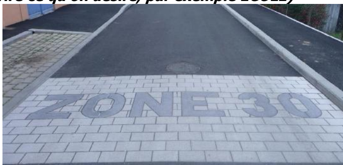
Exemple de marquage transversal avec inscription ZONE30 (mais on peut y faire inscrire ce qu'on désire, par exemple ECOLE)
