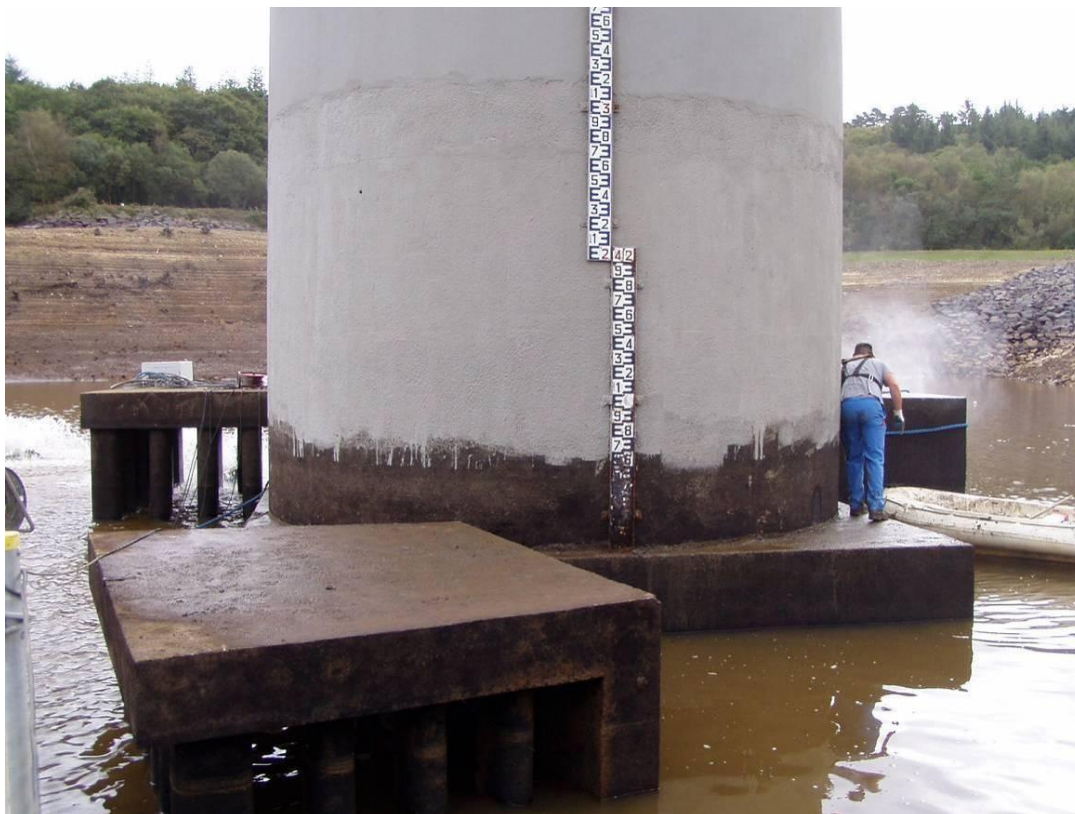
Photo 4 : Vue du pied de la tour tulipe - Entonnement de prise d'eau au premier plan Travaux d'enduit en cours en 2006
