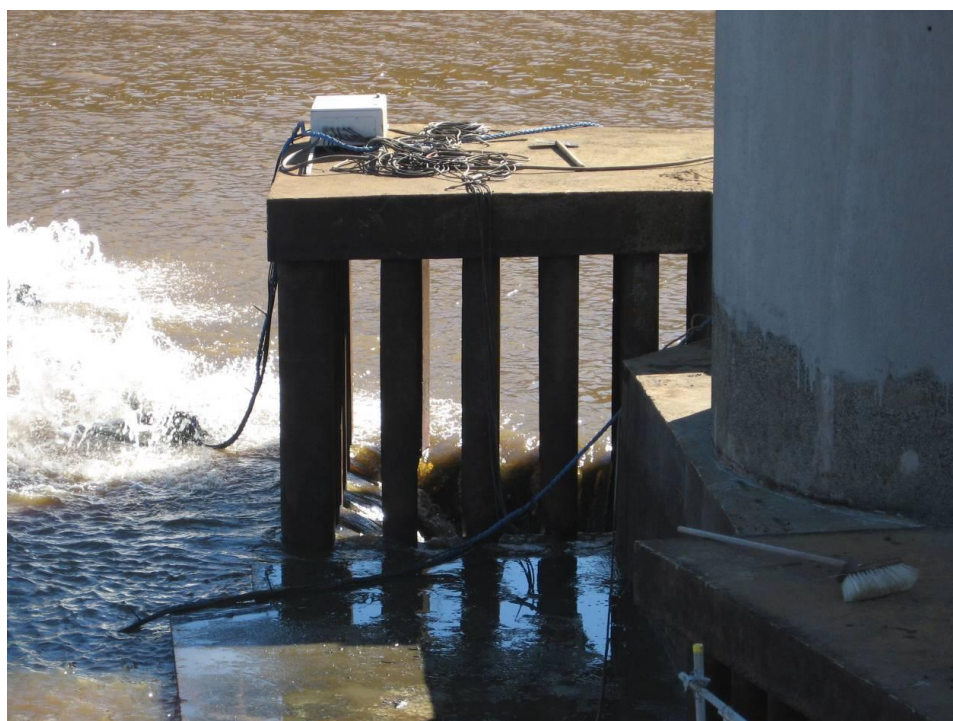
Photo 4 : Vue du pied de la tour tulipe - Entonnement de prise d'eau au premier plan Travaux d'enduit en cours en 2006
