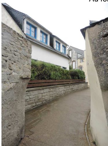
Vue de la façade Sud
