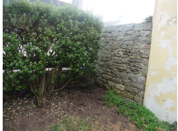
Vue Sud , côté mur ancien presbytère
