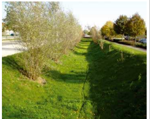
Traitement de bord de RD en noue séparative d'une piste
