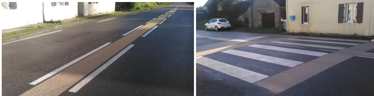
Exemples de séparateurs de voie et de passage piétons « renforcé » en résine/pépites
