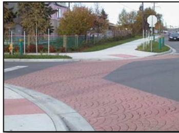
Exemple de matérialisation au sol d'un cheminement réservé (mortier hydraulique)
