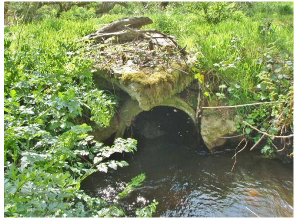
Buse (vue amont de l'ouvrage)
