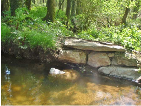
Buse au niveau de la brèche du bief
