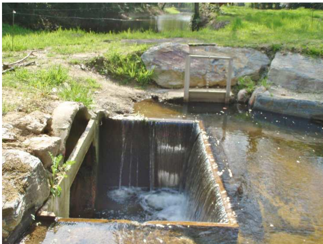
Ouvrage du bras de décharge du bief
