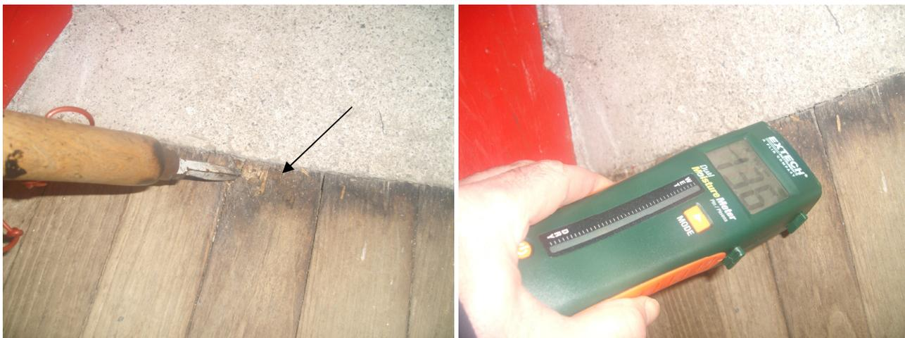
Légère pourriture fibreuse sur le plancher bois au niveau de la porte donnant sur la cour – Humidité de 13,6 %
