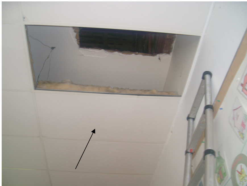
Faux-plafond en panneaux isolant (laine minérale) – Plafond en plâtre au-dessus
