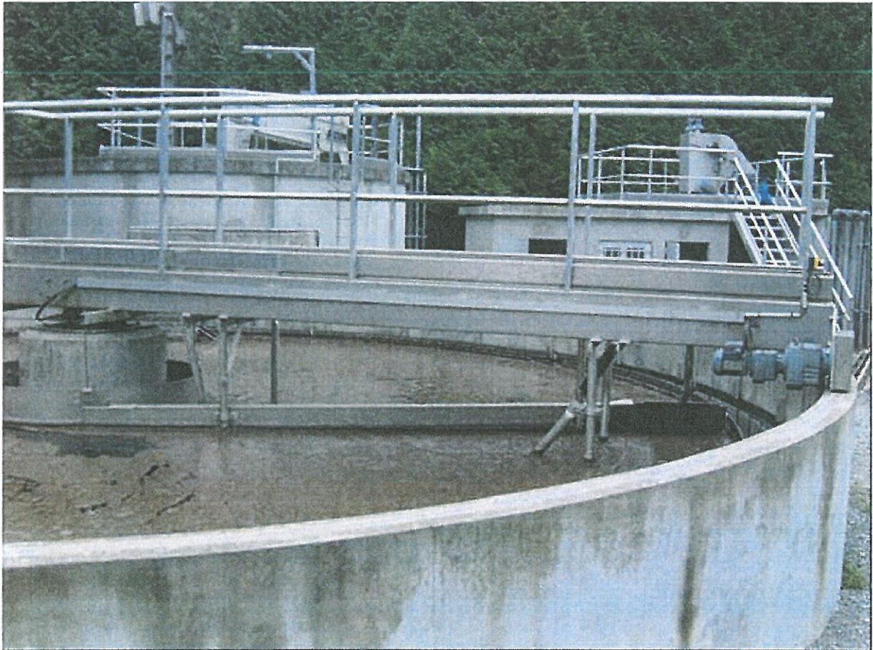
*Photo 3 : Surface d'un clarificateur dont la concentration en boues dans le bassin d'aération n'est pas maîtrisée (concentration excessive)*
