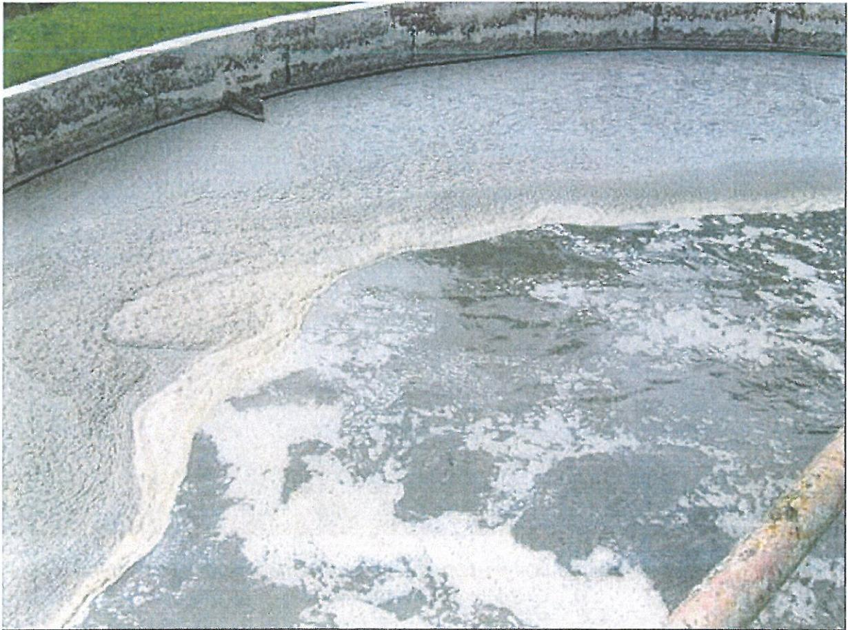
*Photo 4 : Bassin biologique dont l'extraction des boues et l'aération ne sont pas adaptées*
