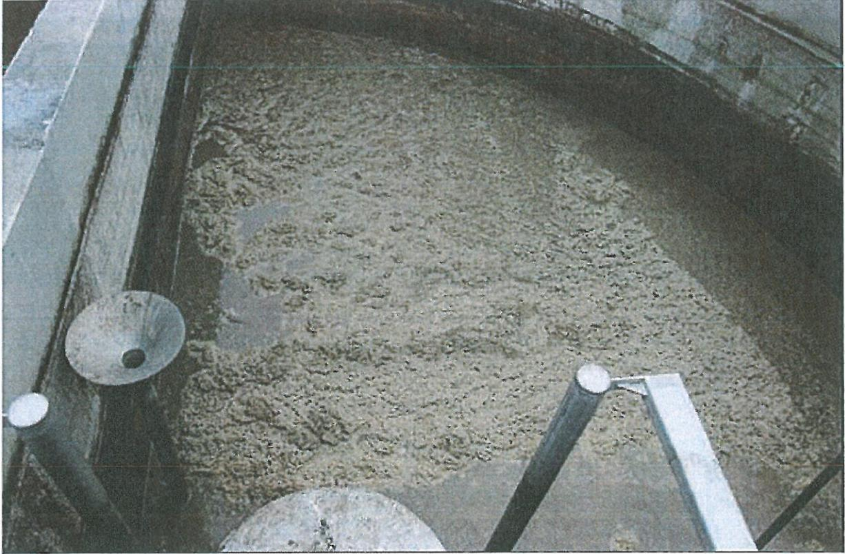
*Photo 5 : Bassin biologique dont les boues sont correctement aérées et la quantité de mousses acceptable.*
