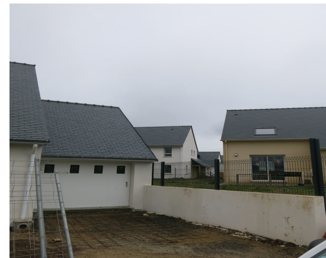
Des extensions récentes en périphérie, au nord est du bourg (10)
