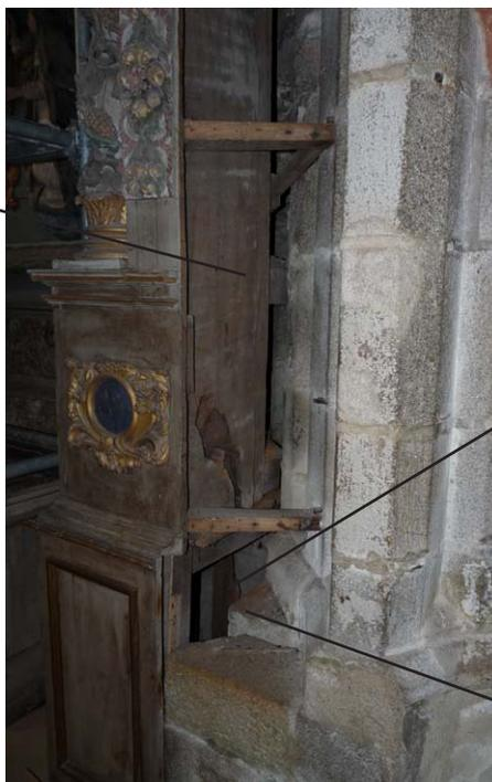
*Après dépose des lames : vues de la structure porteuse attaquées par les insectes xylophages et destabilisée par des fixations rouillées descellées ou cassées*
