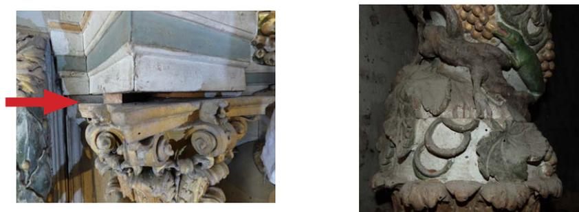
Les ailes latérales sont assemblées au corps central par le revers. On constate de nombreuses interventions sur ces zones particulièrement fragiles et sensibles aux déformations. Des planches plus récentes avec des traces d'usinage et de nombreux raccords de mastic sont clairement repérables. Comme pour le registre inférieur, de multiples pointes oxydées témoignent des interventions successives.
