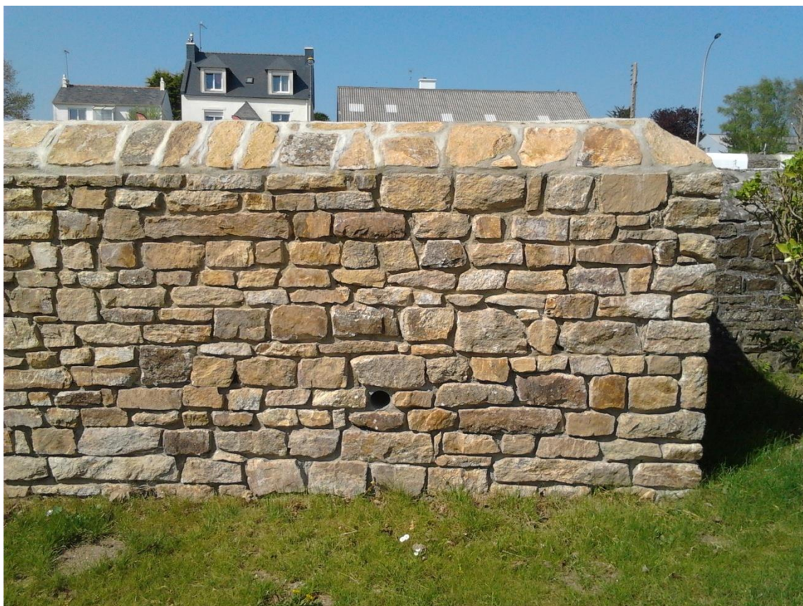
Mur rénové en 2014 : extérieur
