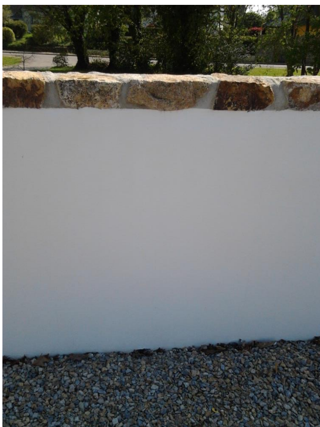
Mur rénové en 2014 intérieur
