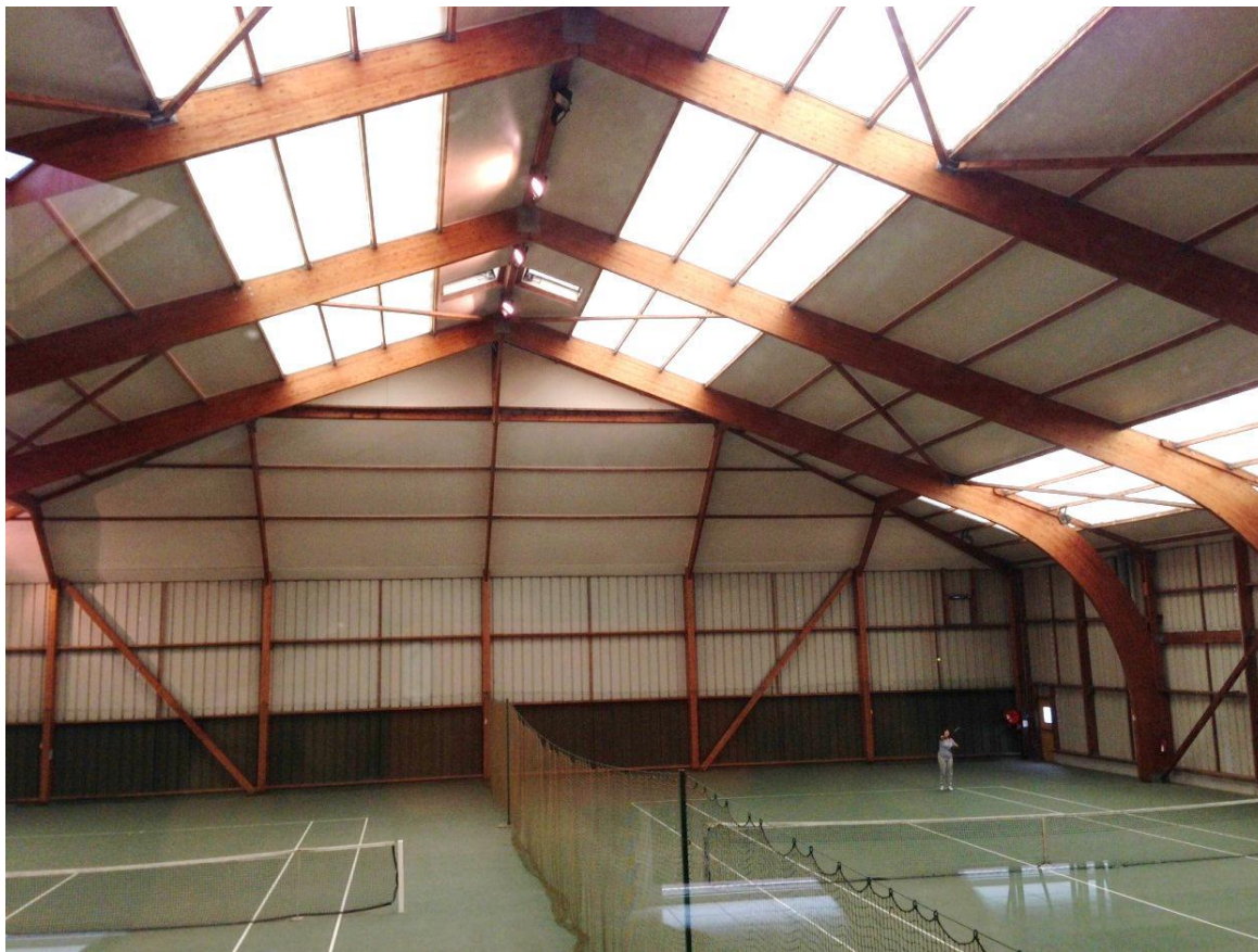
Les courts intérieurs – La photo de gauche met en évidence des traces d'humidité au sol dues aux fuites de la toiture (photo prise fin août après une période sèche).
