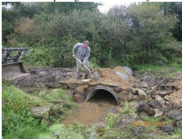
3 - Étalement du remblai de carrière 0/30mm pour finir à une épaisseur minimale de matériaux sur l'arche de 50cm
