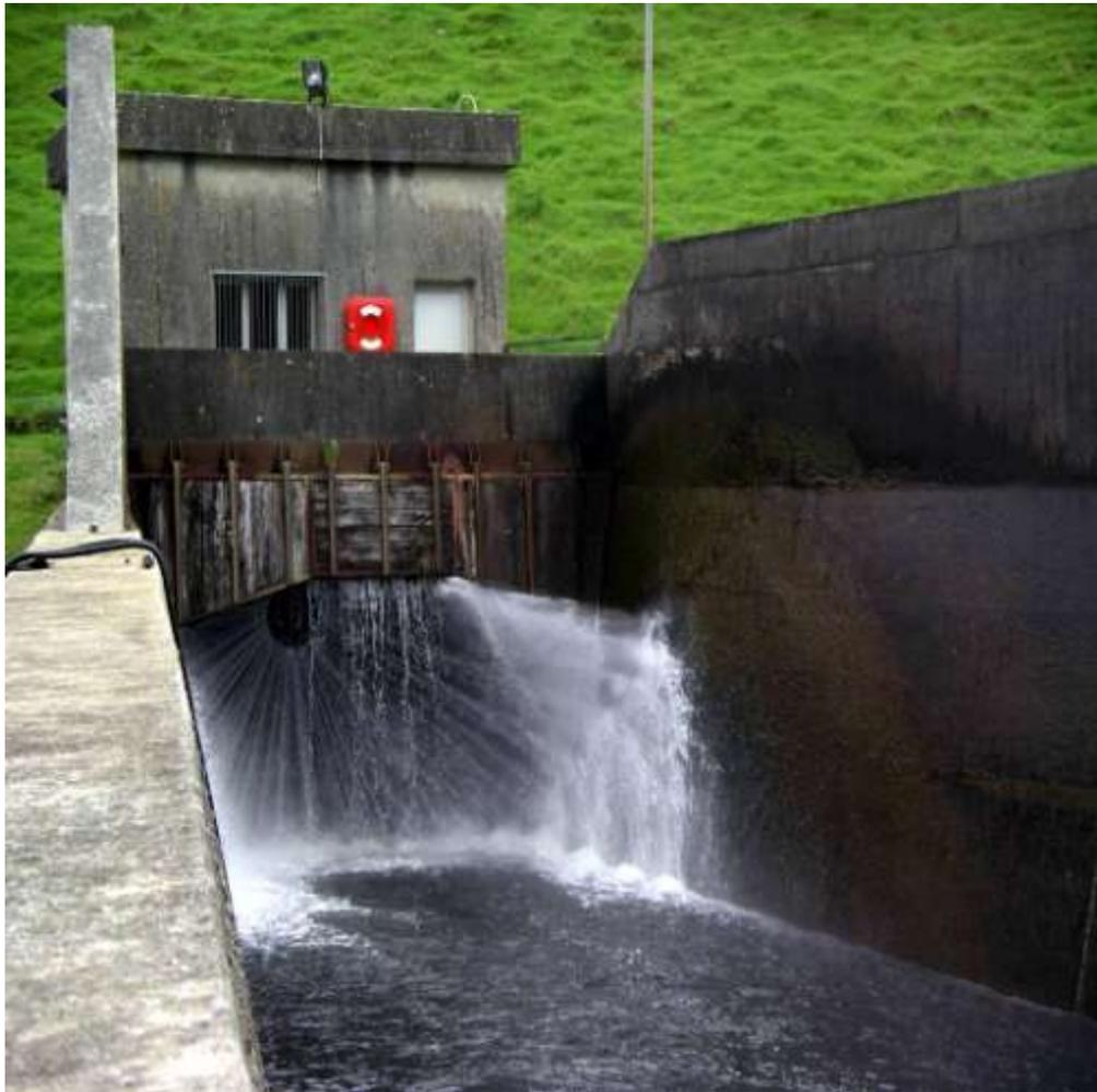
**Figure 2.3 : Vue de l'exutoire du jet creux en aval du barrage**
